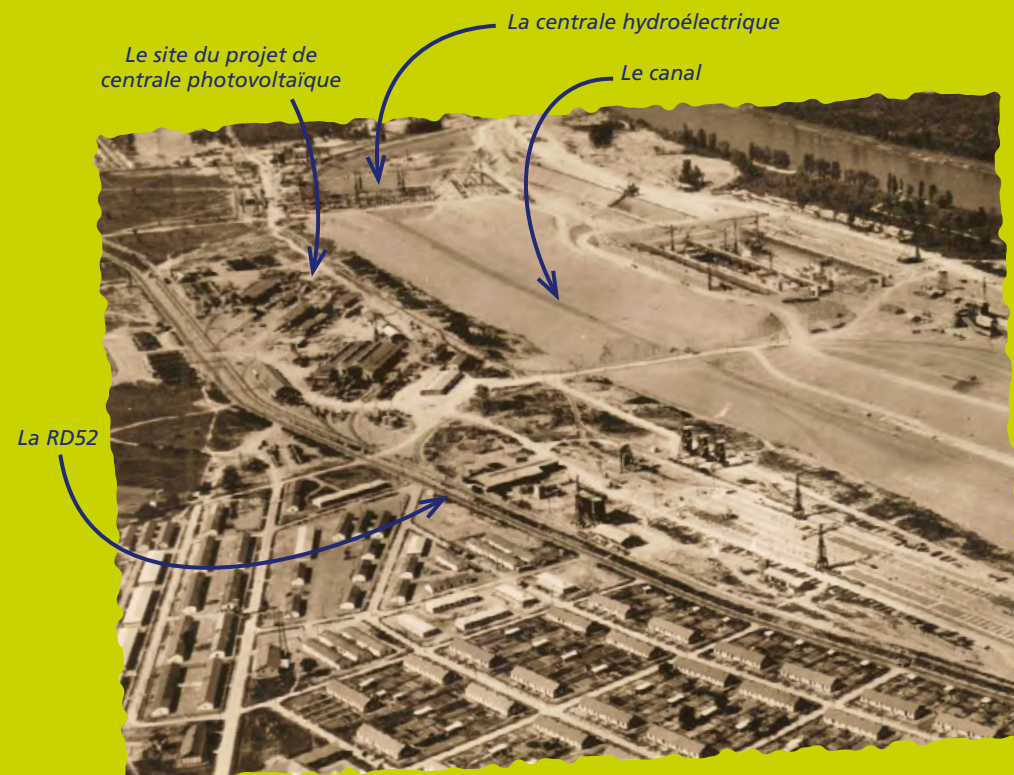
La construction du barrage en 1950, avec la cité de Hombourg Carte postale éditée par EDF en 1950, aimablement mise à disposition par Michel ROUAL
