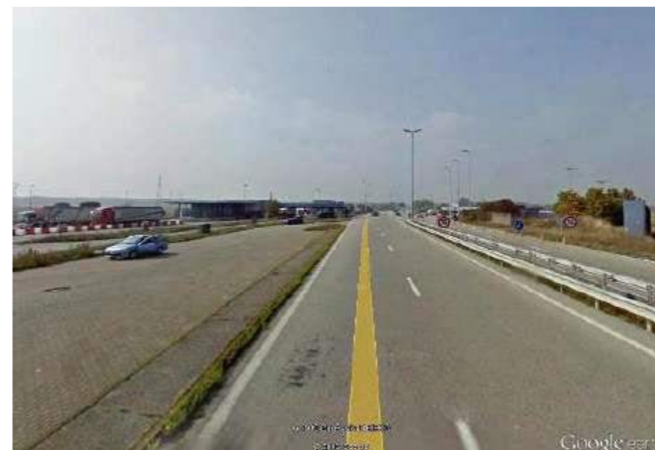
L'entrée sur le territoire français par l'A36 est dégradée, l'intégration paysagère de cet ancien poste frontière en paysage ouvert est faible.
