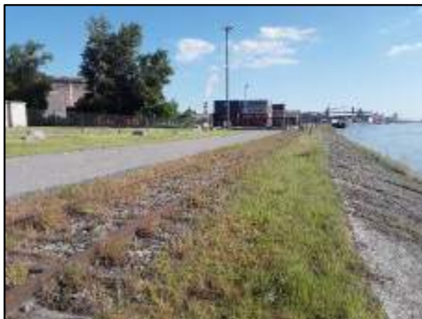
Voies ferroviaires (Rainette, 2021)
