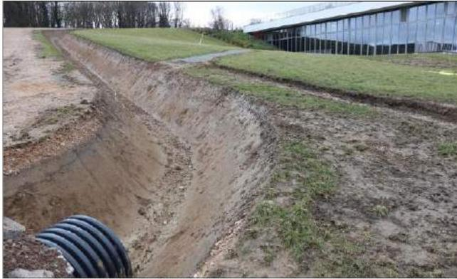
Ce fossé permettra un écoulement sécurisé en cas d'orage.
