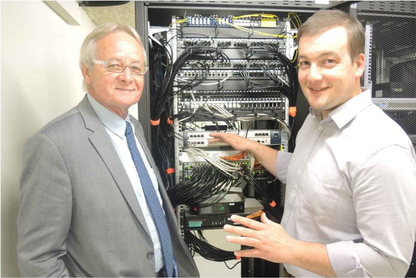
Marck Munck (à gauche) et Cyrille Vogel, en train d'inspecter la salle des serveurs. PHOTO DNA - G.S.
