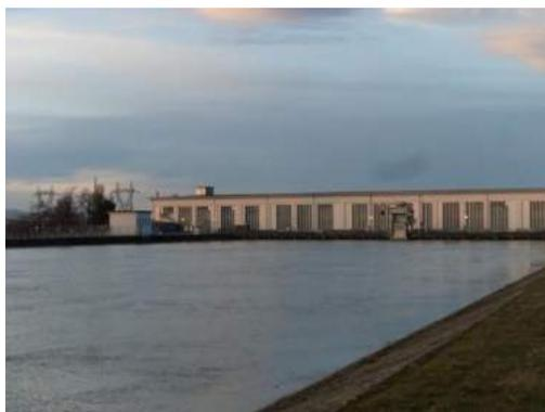
Chaque centrale est associée d'une écluse à 2 sas dont l'exploitation et l'entretien sont assurés par EDF. A chaque éclusée, le sas large reçoit environ 60 000m<sup>3</sup> d'eau et un passage d'écluse dure une vingtaine de minutes. En moyenne, il passe par les écluses du Rhin entre 18 et 20 000 bateaux chaque année.
