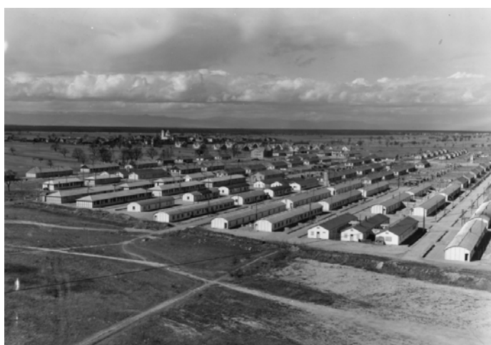
Vue générale de la Gare 9 en 1950
