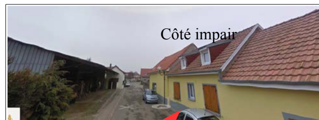
Vue sur le n°3 rue des Serruriers (« repéré » par le SIP, le bâtiment a fait l'objet de transformations).
