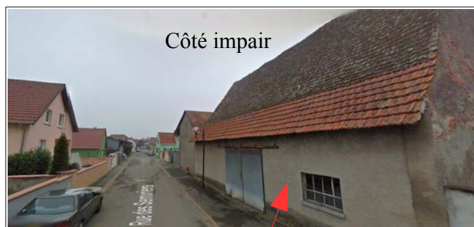
Vue sur l'arrière du 51 rue du Général de Gaulle.
